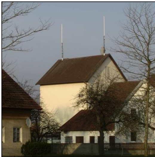
Abb. 1: Beispiel für eine Mobilfunksendeanlage mit omnidirektionalen Antennen.
