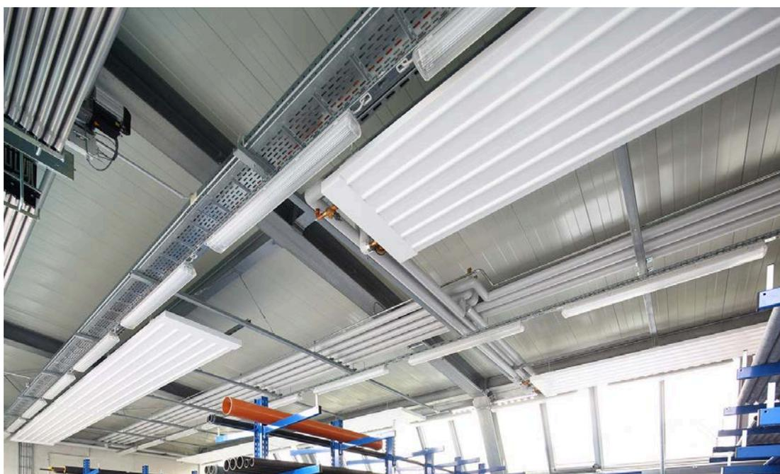
**Abb. 16:** längere Abschnitte von Deckenstrahlplatten.
