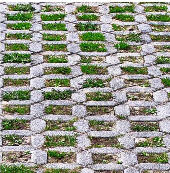
**Abb. 2:** Rasengittersteine ermöglichen eine gute Versickerung des Regenwassers
