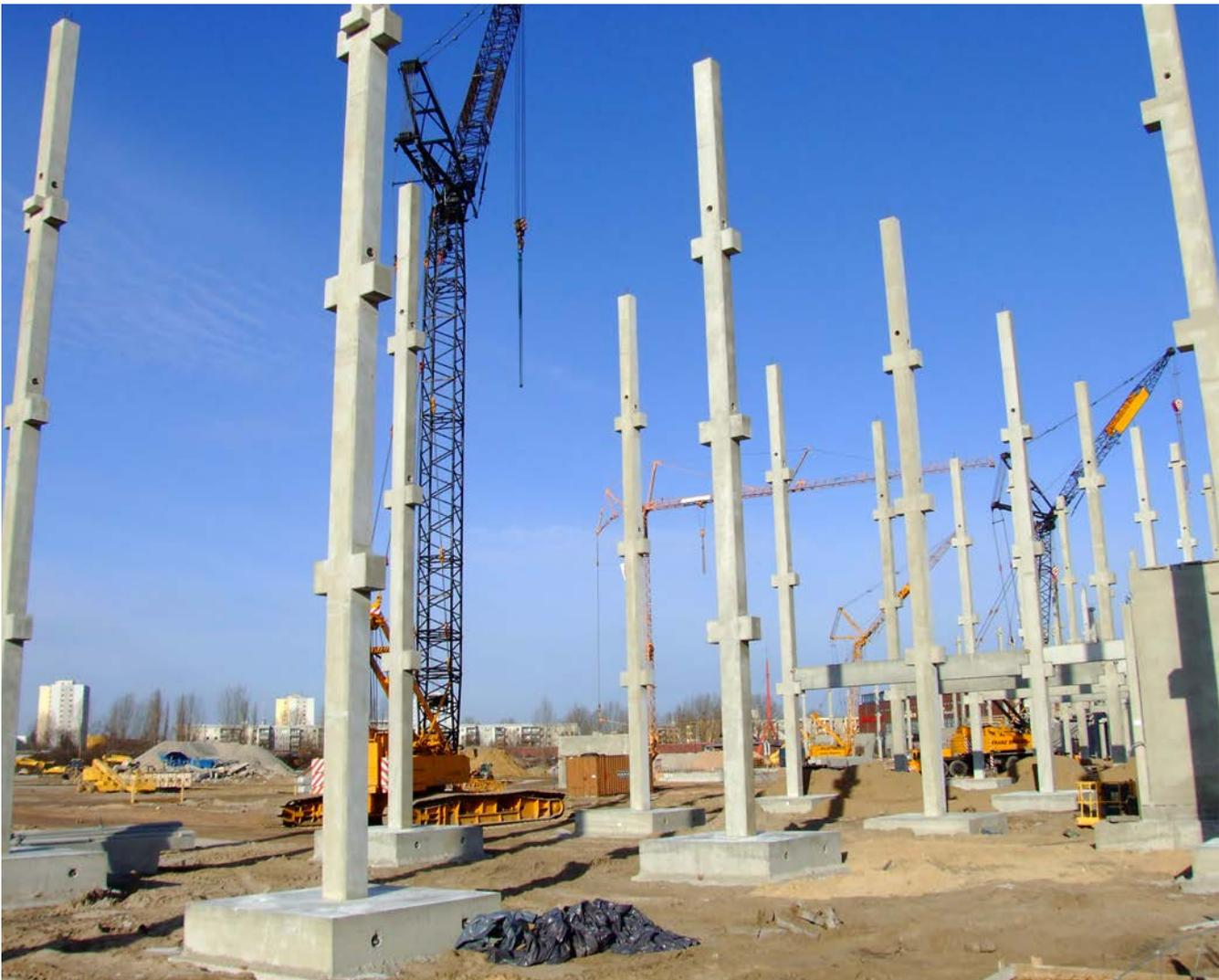
**Abb. 4: Betonpfeiler auf Punktfundament**
