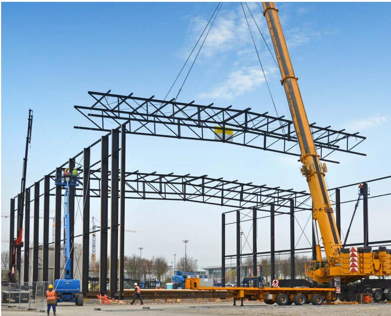
Abb. 5: Montage des Grundgerüsts einer Stahlhalle.
