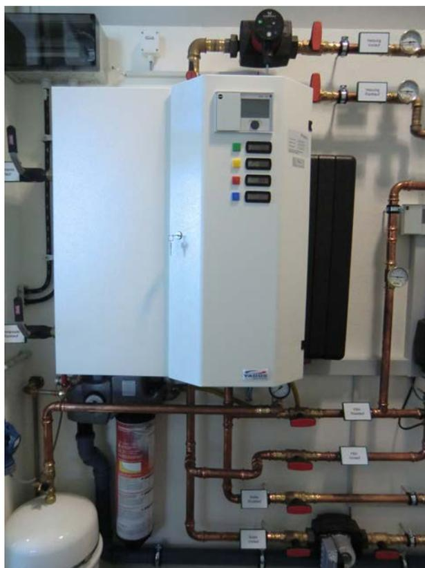
Abb. 14: Einbaubeispiel Wärmeübergabestation.
