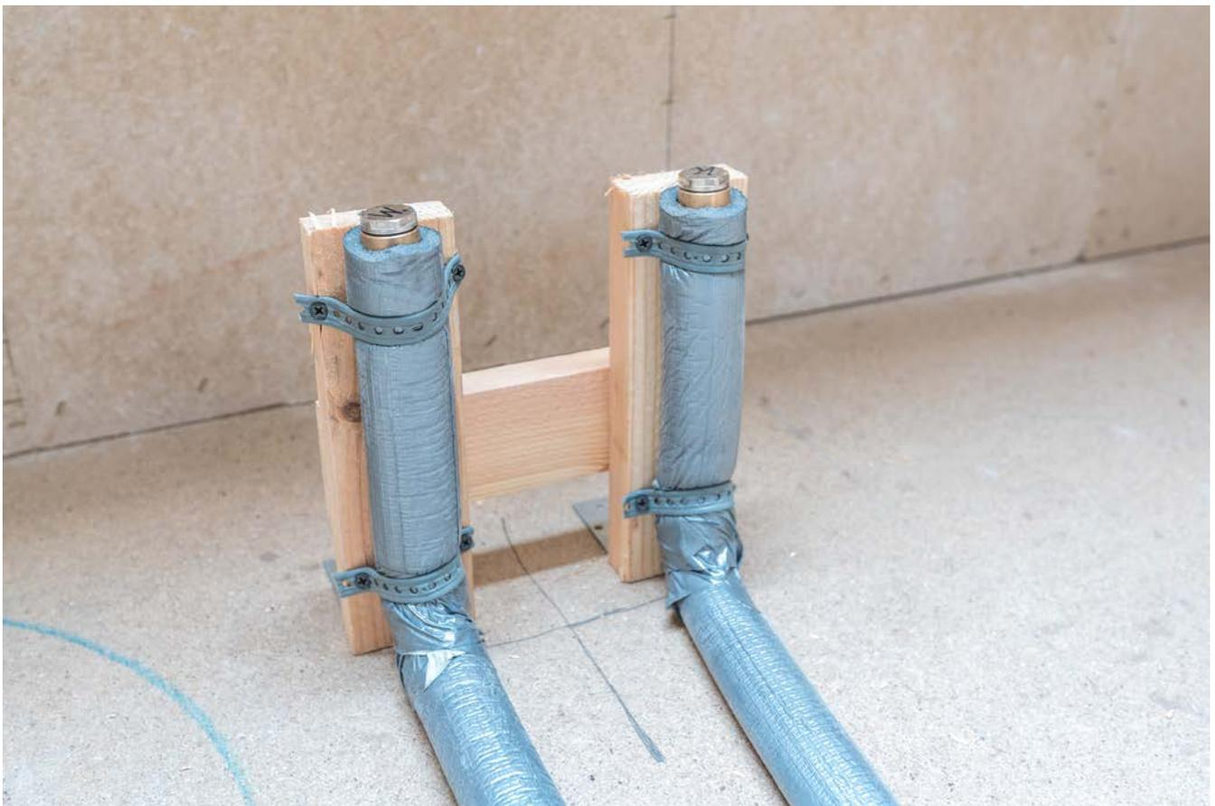
Abb. 10: Gedämmte Rohreitungen
