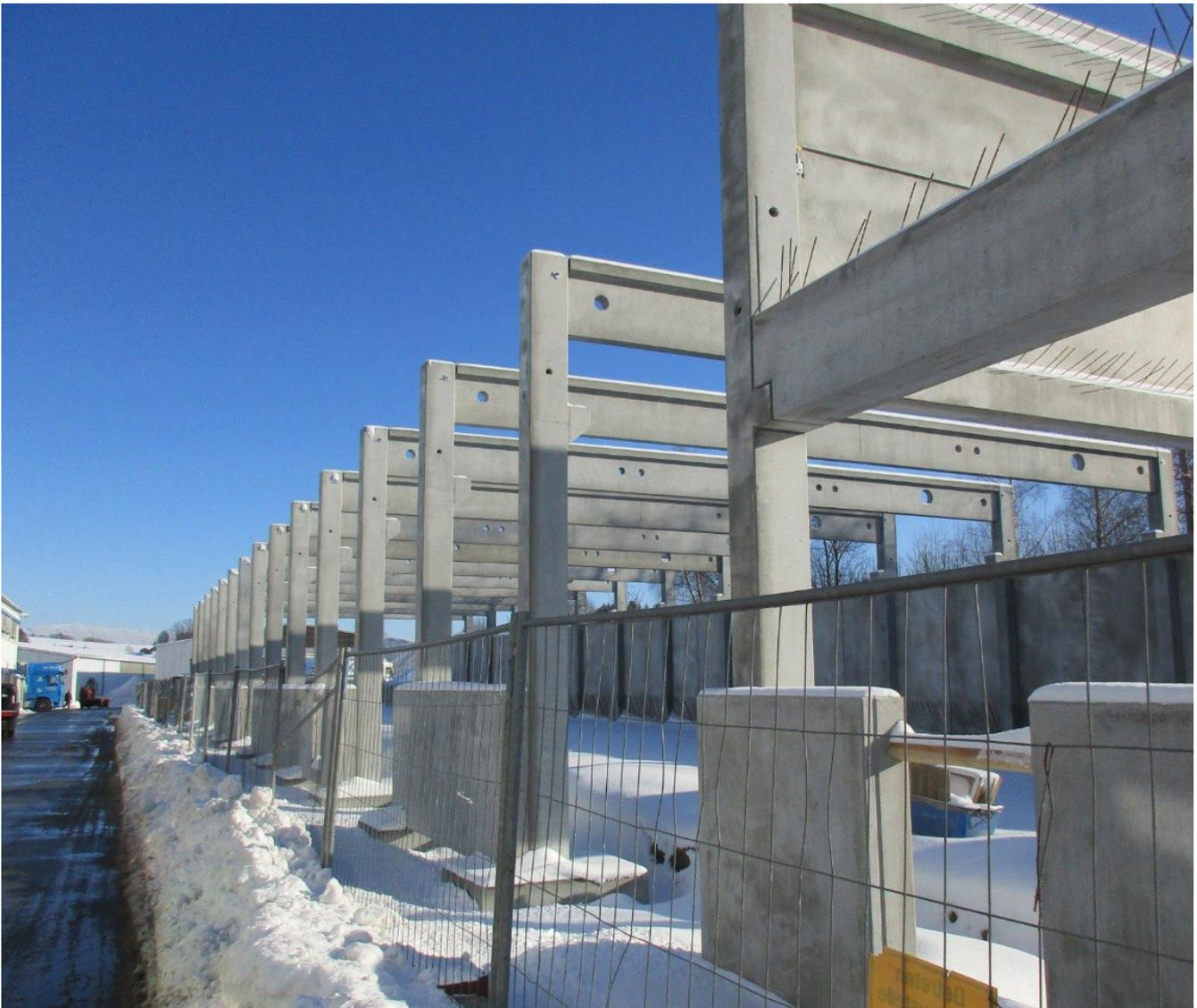
Abb. 6: Säulen aus Stahlbeton
