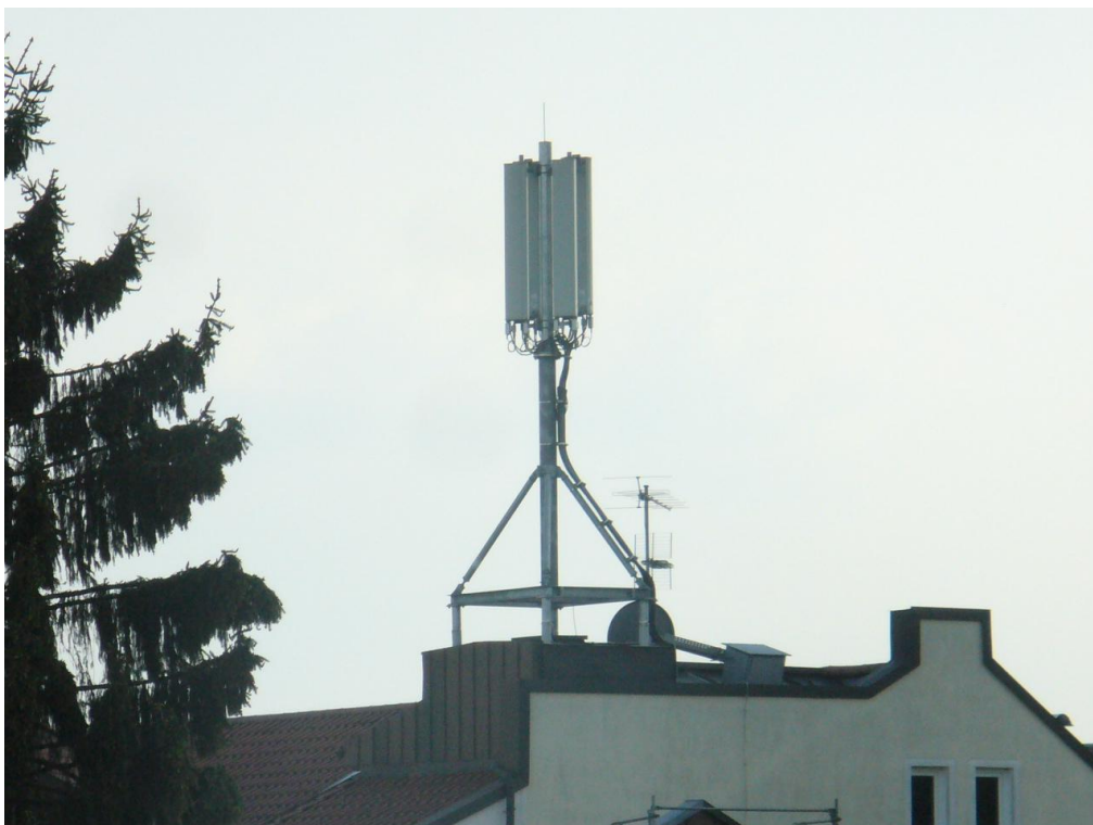
Bild 4: Anlagenstandort von Messpunkt 4 aus gesehen
