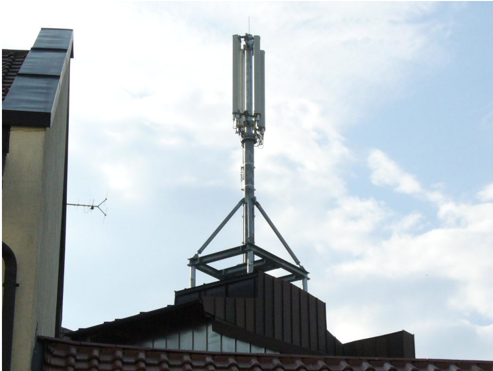
Bild 7: Anlagenstandort von Messpunkt 7 aus gesehen
