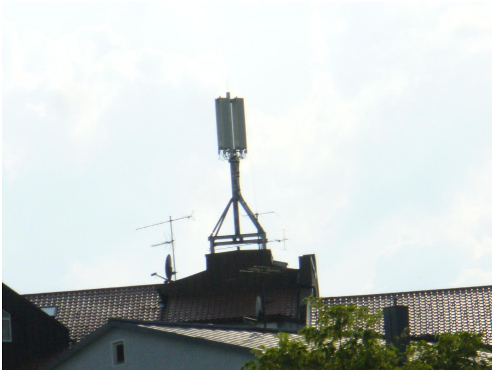
Bild 1: Anlagenstandort von Messpunkt 1 aus gesehen
