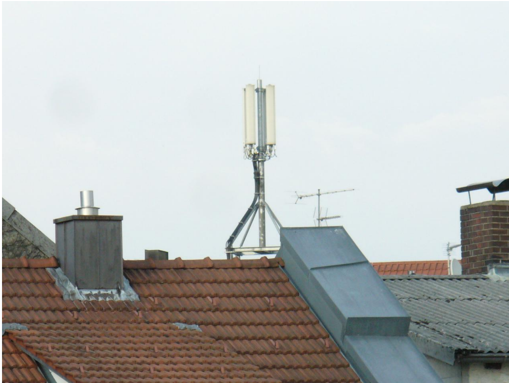
Bild 9: Anlagenstandort von Messpunkt 13 aus gesehen
